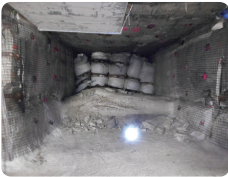
Illustrations de la dégradation de la tenue minière dans le bloc 12.
