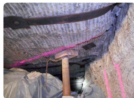
Le chantier du bloc 12 fin mars 2017 : vue sur les décollements et les lames posées au toit lors du creusement du bloc.
