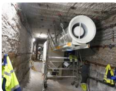
(1) Installation du dépoussiéreur.
