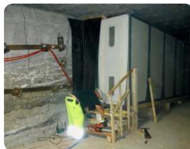
(3) Mise en place du sas de décontamination.
