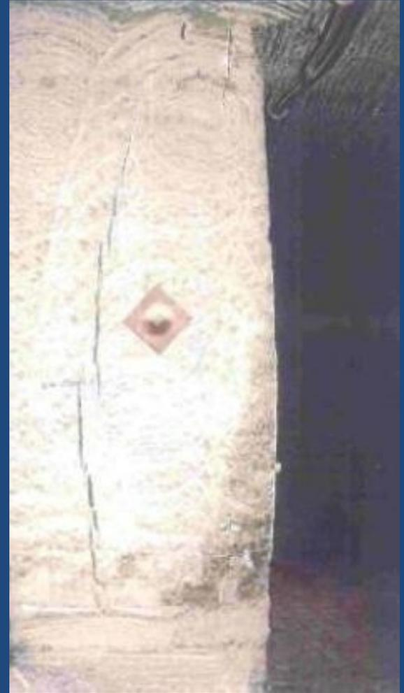
3. *Suite*. La section initiale des galeries était 5,5 m x 2,80 m ; la vitesse de fermeture actuelle moyenne est de l'ordre de 3 à 5 cm par an mais de plus, le premier banc au toit et au mur (au moins) est décollé. Le risque est la chute de blocs.
