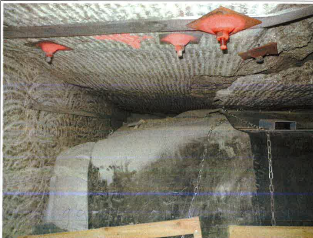
StocaMine / Bloc 21. Galerie 21/2, ou nord-est de la recoupe R7 ; en direction du nord-est, vue sur la situation actuelle des travaux de déblaiement. Parement nord-ouest avec une plaque en biseau décollée du toit. Situation globale plutôt favorable, permettant une sécurisation maîtrisée pour le déstockage. Détail de la photo n° 18/2015 du 07 septembre 2015.
