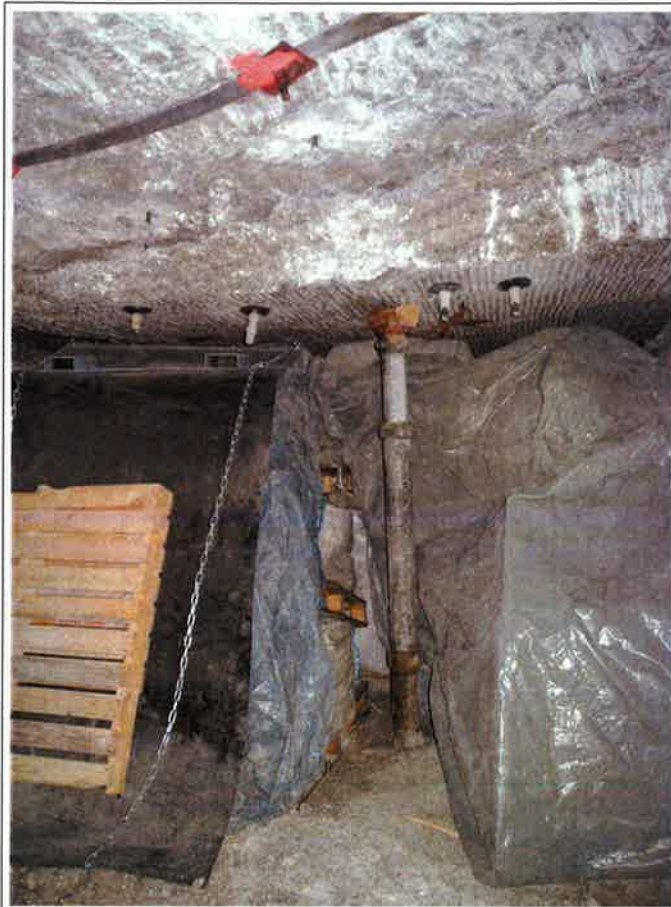
StocaMine / Bloc 21. Galerie 21/2, ou nord-est de la recoupe R7 ; en direction du nord-est, vue sur la situation actuelle des travaux de déblaiement. Sécurisation de la plaque en biseau du toit décollée au niveau du parement sud-est à l'aide de boulons et d'un étançon isolé. Détail de la photo n° 18/2015 du 07 septembre 2015.
