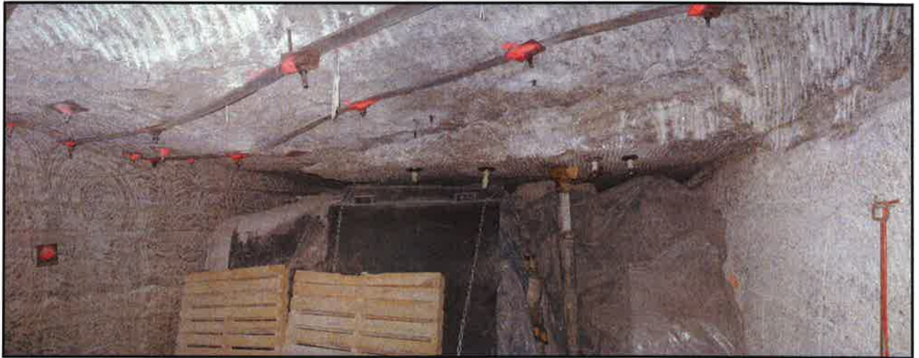
Photo panoramique de l'état d'avancement actuel des travaux de déblaiement dans la galerie 21/2, en direction du nord-est
