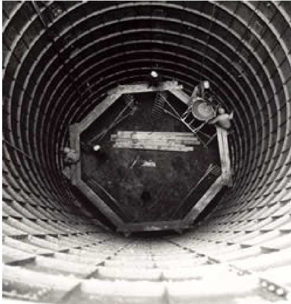
Cuvelage puits Rodolphe
