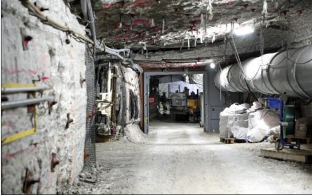
Des parois pleines de boulons d'acier (à gauche), un toit boulonné en fibre de verre, des conduits d'aération, des sas à foison... Image d'une mine en chantier.
