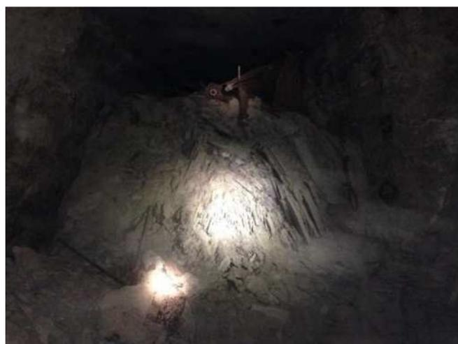
Figure 11 : Photographie du phénomène de soufflage du mur
