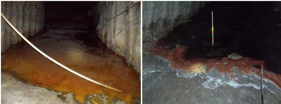
Deux photos, prises en octobre 2009 et août 2012, du TB 88, intersectant le parcours de l'eau d'infiltration en provenance du puits Amélie 1 et en direction des vieux travaux situés plus au Nord.
