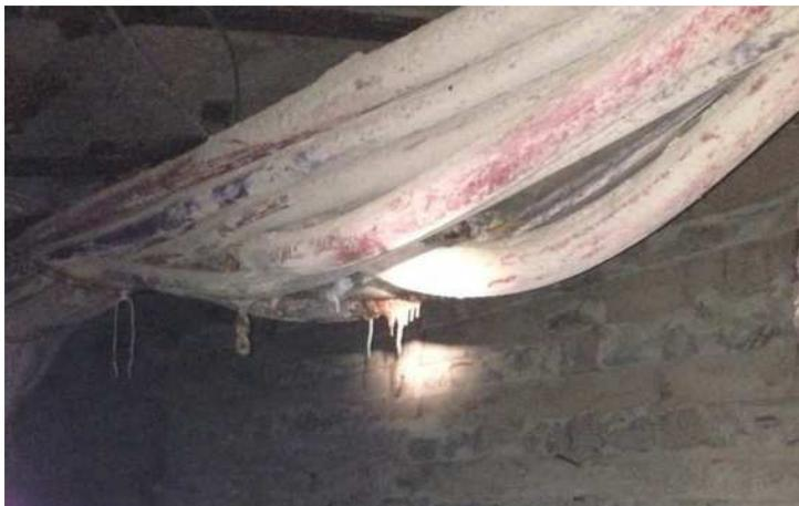
**Figure 7 : Photographie d'un câble comportant un suintement de saumure**
