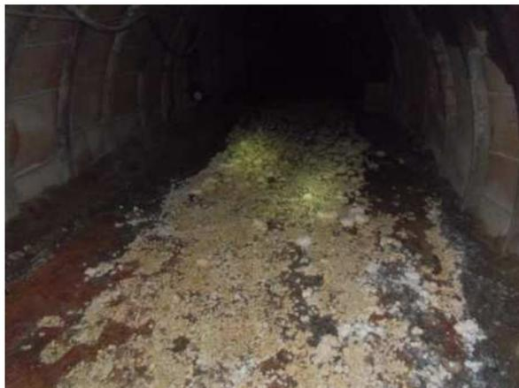
Août 2012 : le TB 66 s'est complètement asséché au niveau du mur, présence de concrétions de sel. Des sondages forés dans le mur montrent eux aussi une cristallisation et un assèchement. Deux hypothèses sont possibles : soit les apports d'eau ont nettement diminué, soit le chemin parcouru par l'eau évolue, en profondeur ou en direction. Une conjonction des deux phénomènes est également possible.
