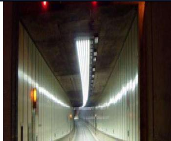
L'éclairage de secours est relié au système d'éclairage temporaire à pile garantissant un minimum de 3 heures d'éclairage.
