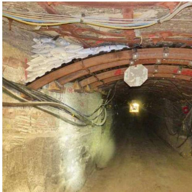
Figure 3 - Soutènement du toit de type casquette dans la galerie AQ1D
