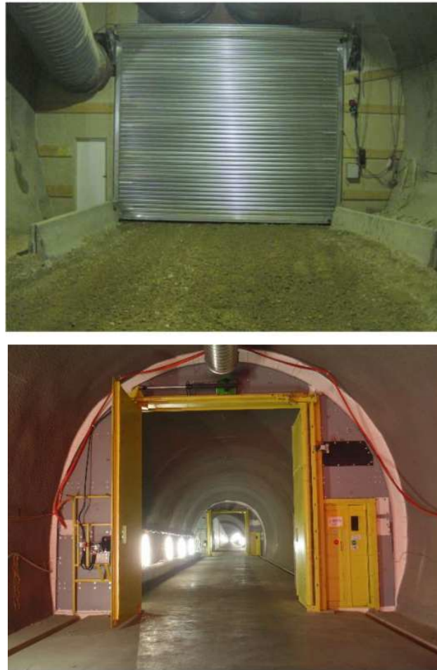
Figure 9 : Porte palière de compartimentage (en haut) – porte coulissante « type kiosque » (en bas)
