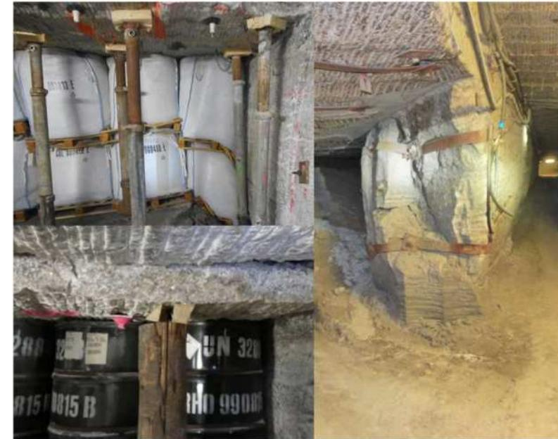
Mesures des taux de convergence dans les galeries (hors blocs de stockage) de **30 mm/an en moyenne** avec une grande variabilité (entre 20 et 40 mm/an)
