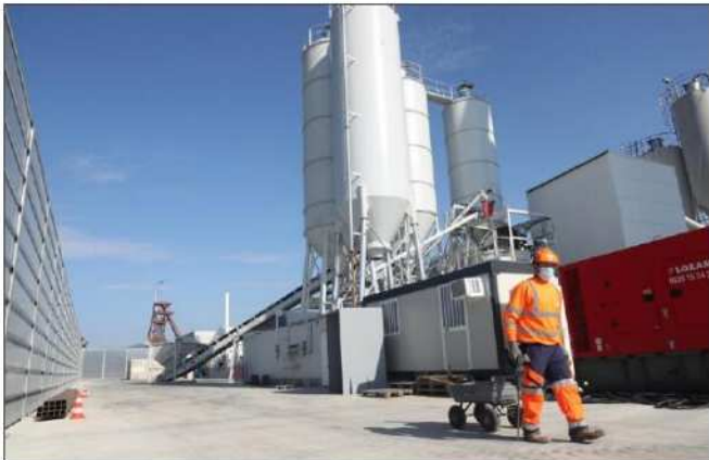
Les deux centrales à béton installées par Bouygues TP pour confiner les déchets stockés à Wittelsheim seront opérationnelles à partir du mois d'octobre. Photo L'Alsace/Darek SZUSTER
