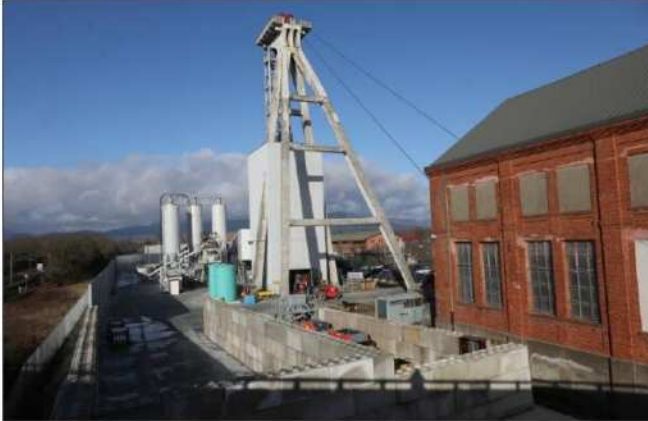
Le chantier, avec le remblayage des blocs vides et du bloc 15, devrait débuter dans un mois. Photo L'Alsace/Vincent VOEGTLIN
