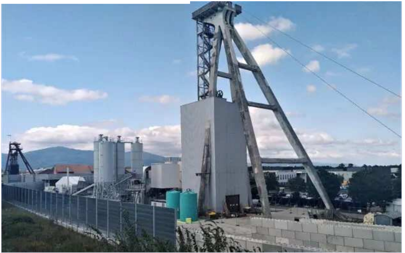
La structure pour couler le béton est en place depuis l'été 2021. (Photo remise)
