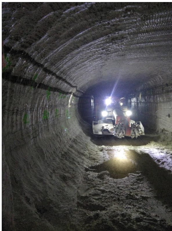
>Travaux préparatoires miniers du barrage 1
