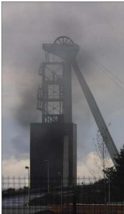
L'incendie survenu le 10 septembre 2002 est dû à l'auto-combustion par fermentation de déchets phytosanitaires provenant d'un incendie de l'entreprise Solupack. Archives L'Alsace/Serge REALINI
