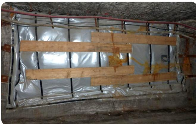
> ***L'un des barrages d'aérage empêchant la circulation de l'air.***
