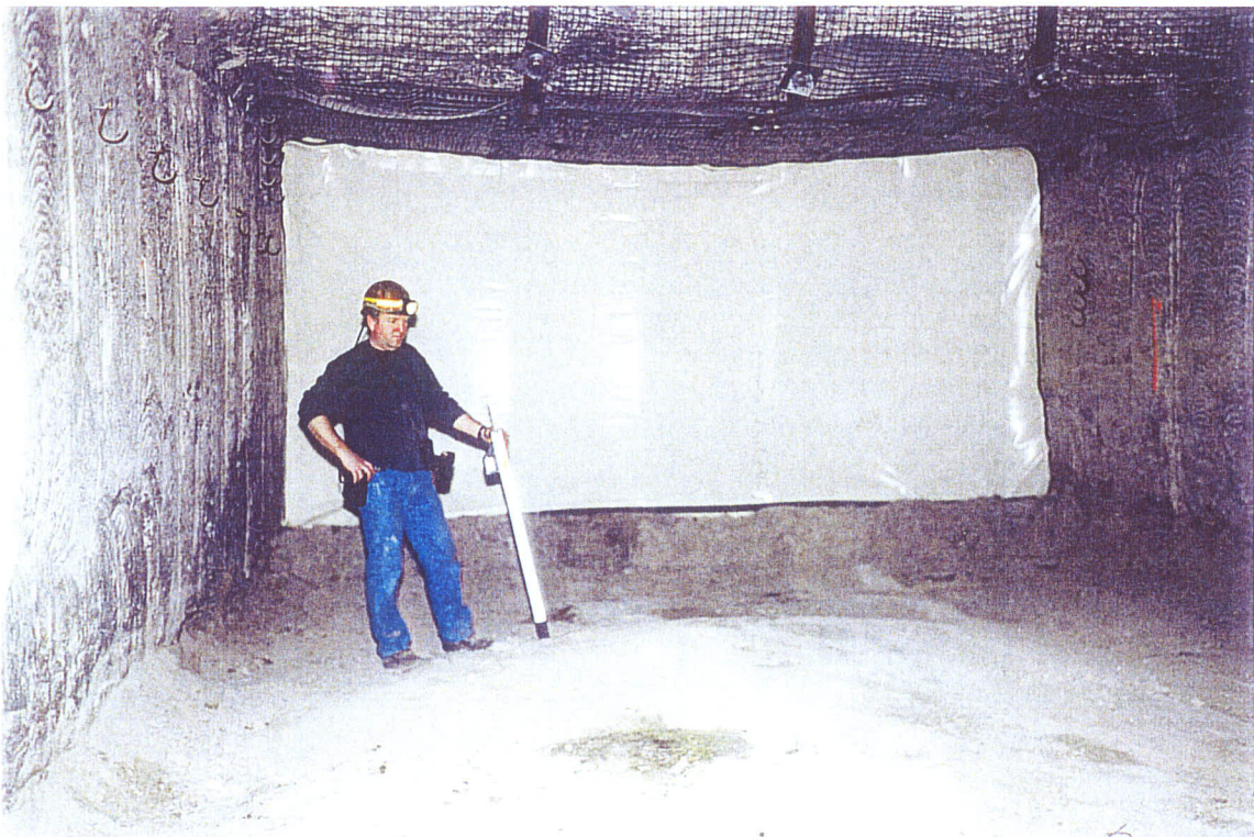
Vue d'un bloc de stockage de déchets, fermé par une cloison souple
