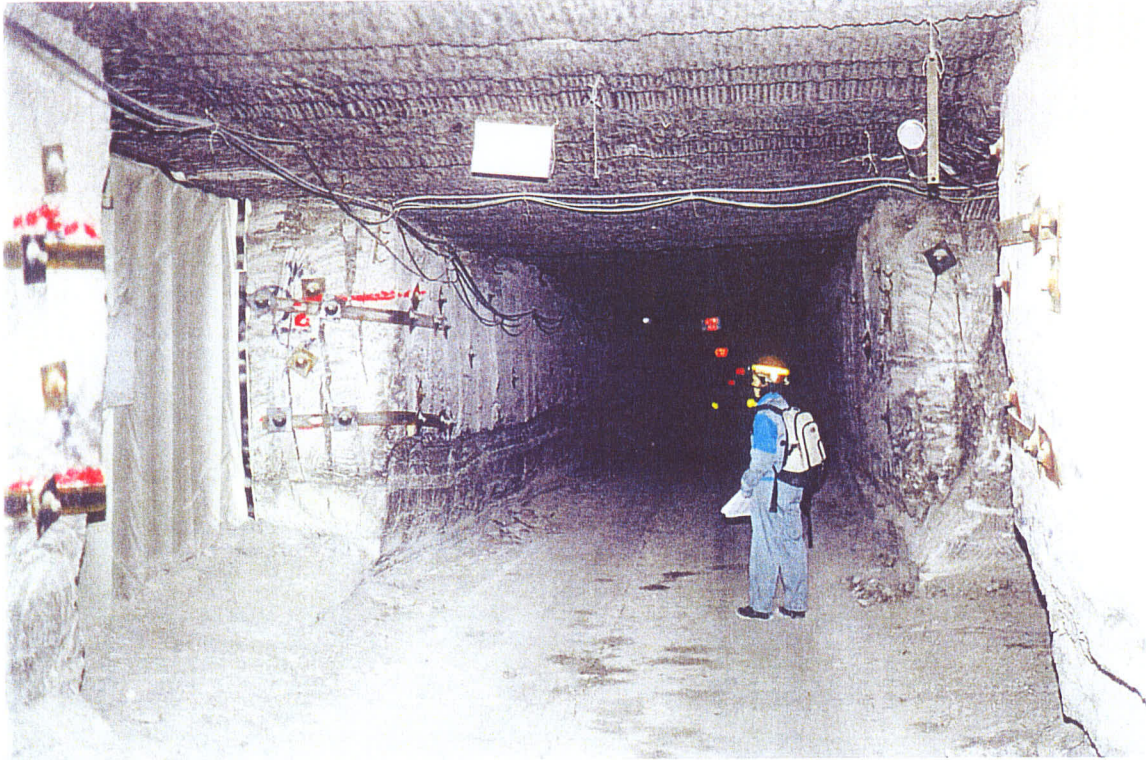
Vue de l'allée centrale de desserte des blocs de stockage
