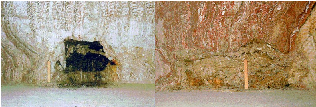
Fig. 31. Fermeture des vides souterrains ; observations dans la mine de sel de Asse d'une galerie en partie remblayée (résidus de lixiviation à chaud de la potasse) – échelle graphique environ 30 cm
