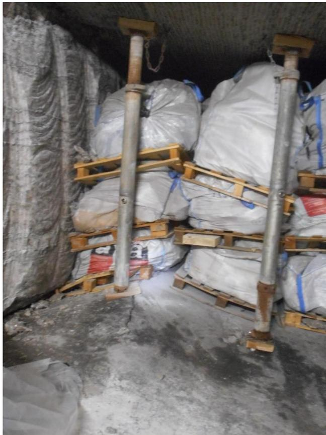
Figure 25 : Exemple d'un front de big bag confronté à la convergence des terrains avec un début d'enclavement
