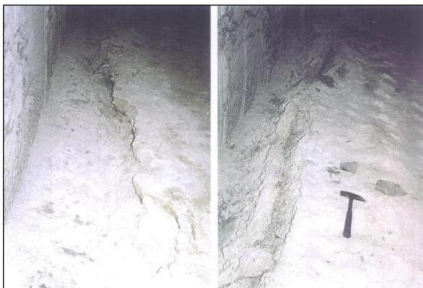
Figure 10 : Soufflage du mur (d'après MICA)
