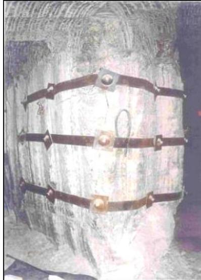
Figure 4: Déformation et écaillage du pilier séparant les galeries de la voie double de desserte (d'après MICA)
