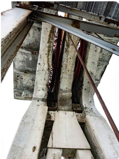
> La corrosion du chevalement du puits Else.
