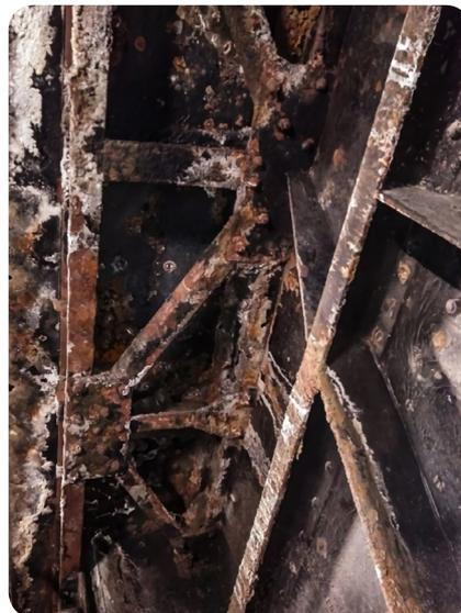
> La corrosion au niveau de l'ancrage des câbles guides du puits Else.
