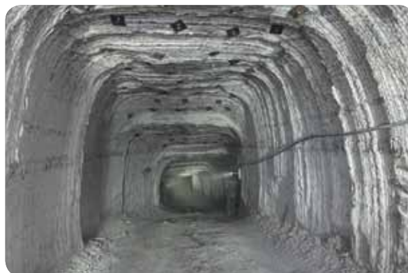
Le boulonnage du toit
