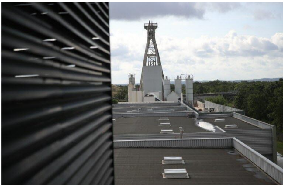
Le chevalement de Stocamine à Wittelsheim. /Photo Vincent Voegtlin
