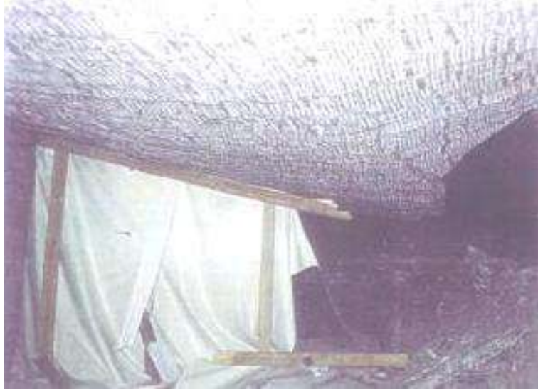
Décollement du toit au niveau -25 m de foudroyage dans les blocs 16 et 26 (non occupés par le stockage)
