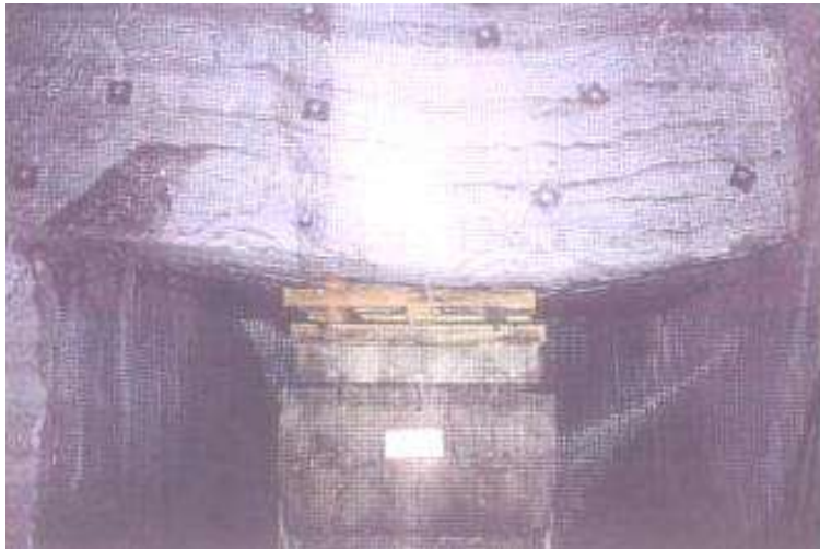
Décollement du toit au niveau -25 m de foudroyage dans les blocs 16 et 26 (non occupés par le stockage)
