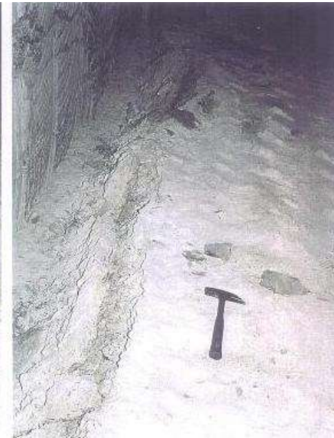
Soufflage du mur d'une allée
