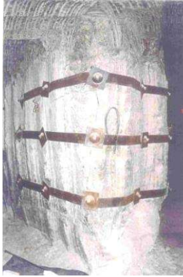
Rupture d'un pilier de voies doubles
