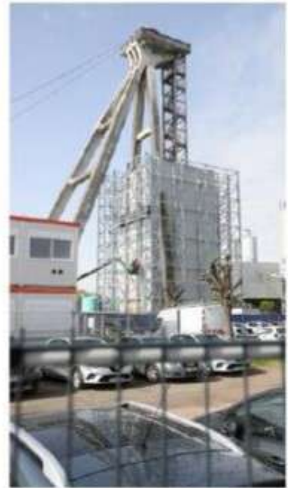
Le renforcement du faux carré du chevalement Joseph-Else, à Wittelsheim, est le chantier le plus visible sur le site de Stocamine.
