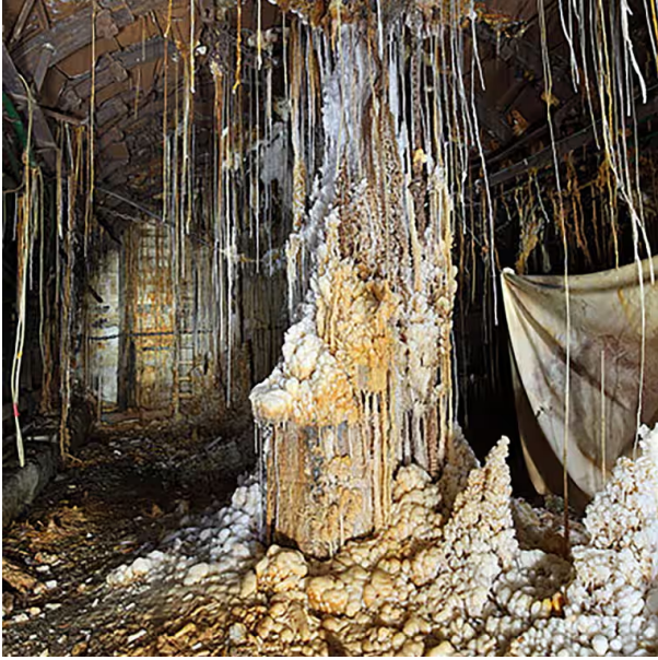
📷 Une photographie prise au fond d'un des puits de mine en 2016. L'eau a quand même réussi à pénétrer malgré le bétonnage et le remblayage du puits.
